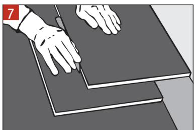
**7** Einpassen der letzten Dielenreihe: Legen Sie exakt auf die zuletzt verlegte Dielenreihe die nachzusägende Diele. Dann zeichnen Sie mit Hilfe einer weiteren Dielenleiste den Längsschnitt an. Durch diese Art des Anzeichnens bleibt genügend Abstand zur Wand um die letzte Reihe mittels Zugeisen einzuwinkeln.
